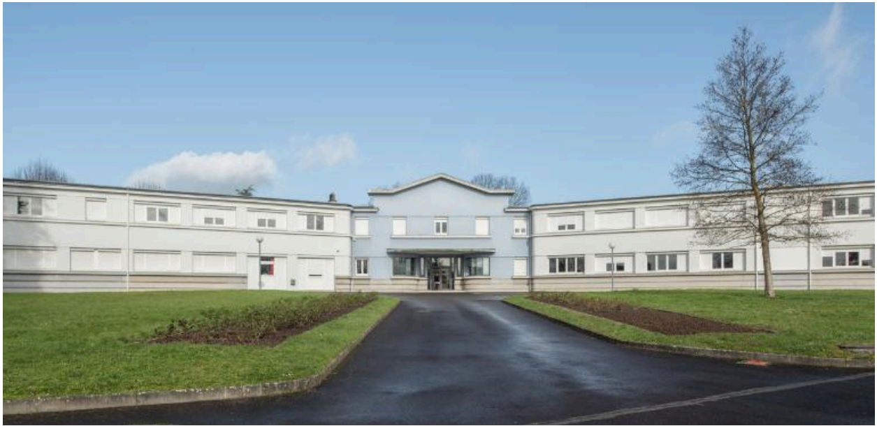
Bâtiment C, internat-externat, vue d'ensemble de la façade sud, prise dans l'axe de l'entrée principale. (Albert Hec, architecte).
