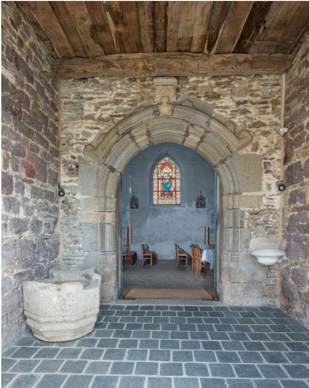
Porche d'entrée, portail sud
