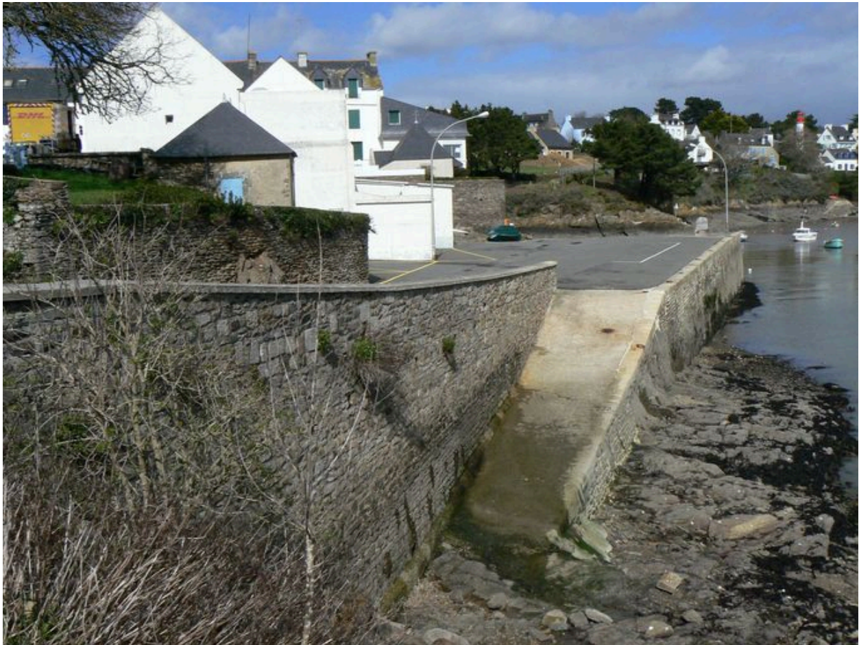
Quai Peyron et cale vus d'aval
