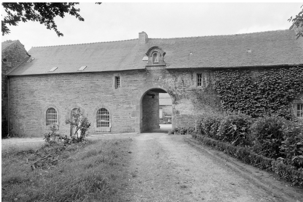
Aile nord : élévation nord est
