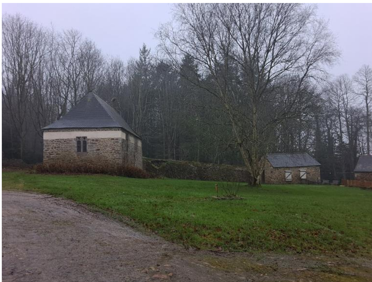
Chapelle, façade nord
