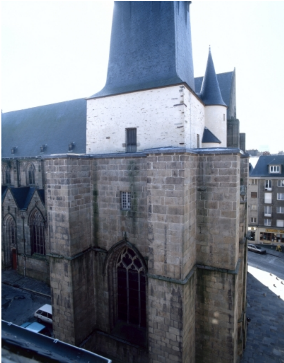
Elévation nord, clocher : vue générale
