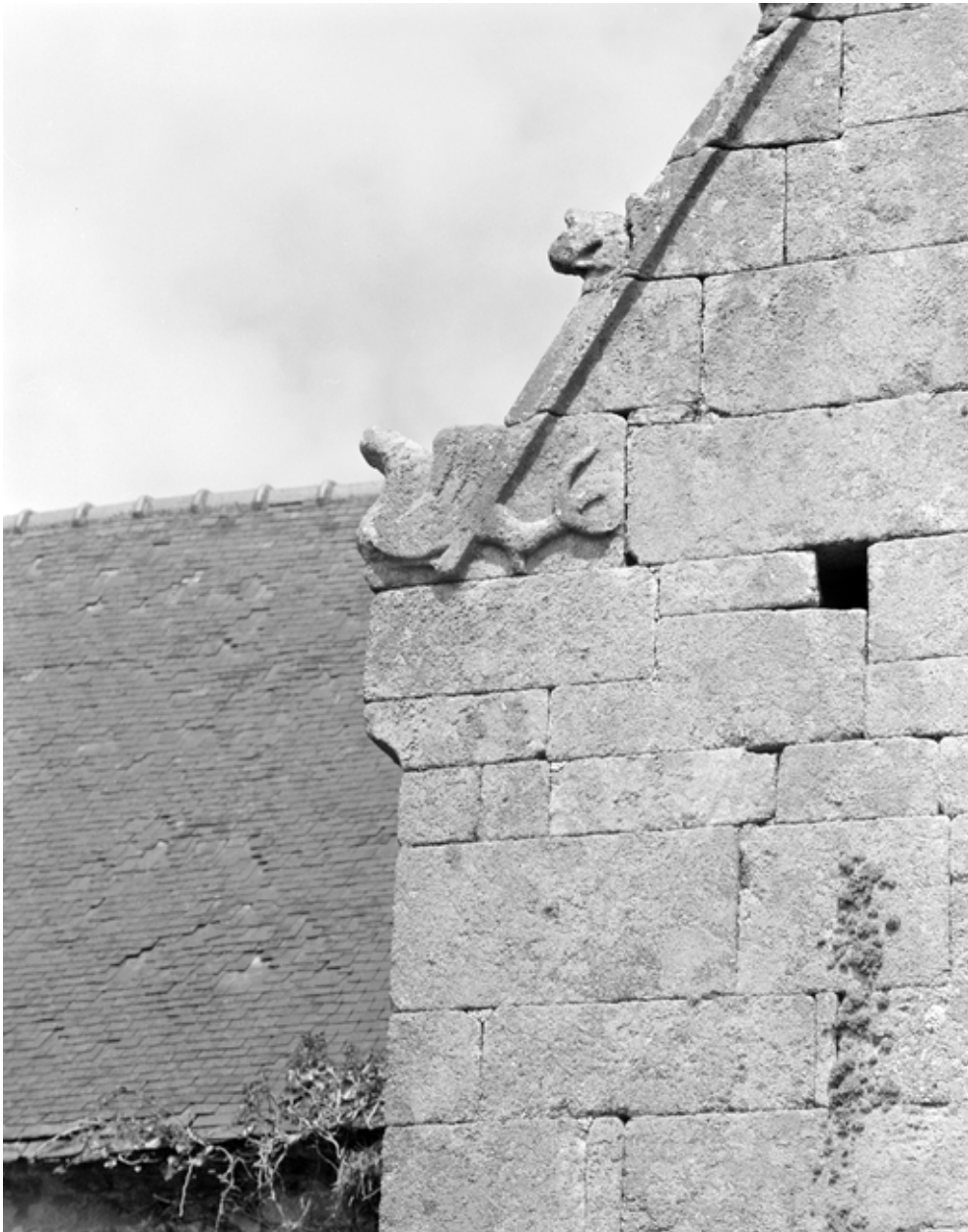
Détail des crossettes de rampants nord et sud
