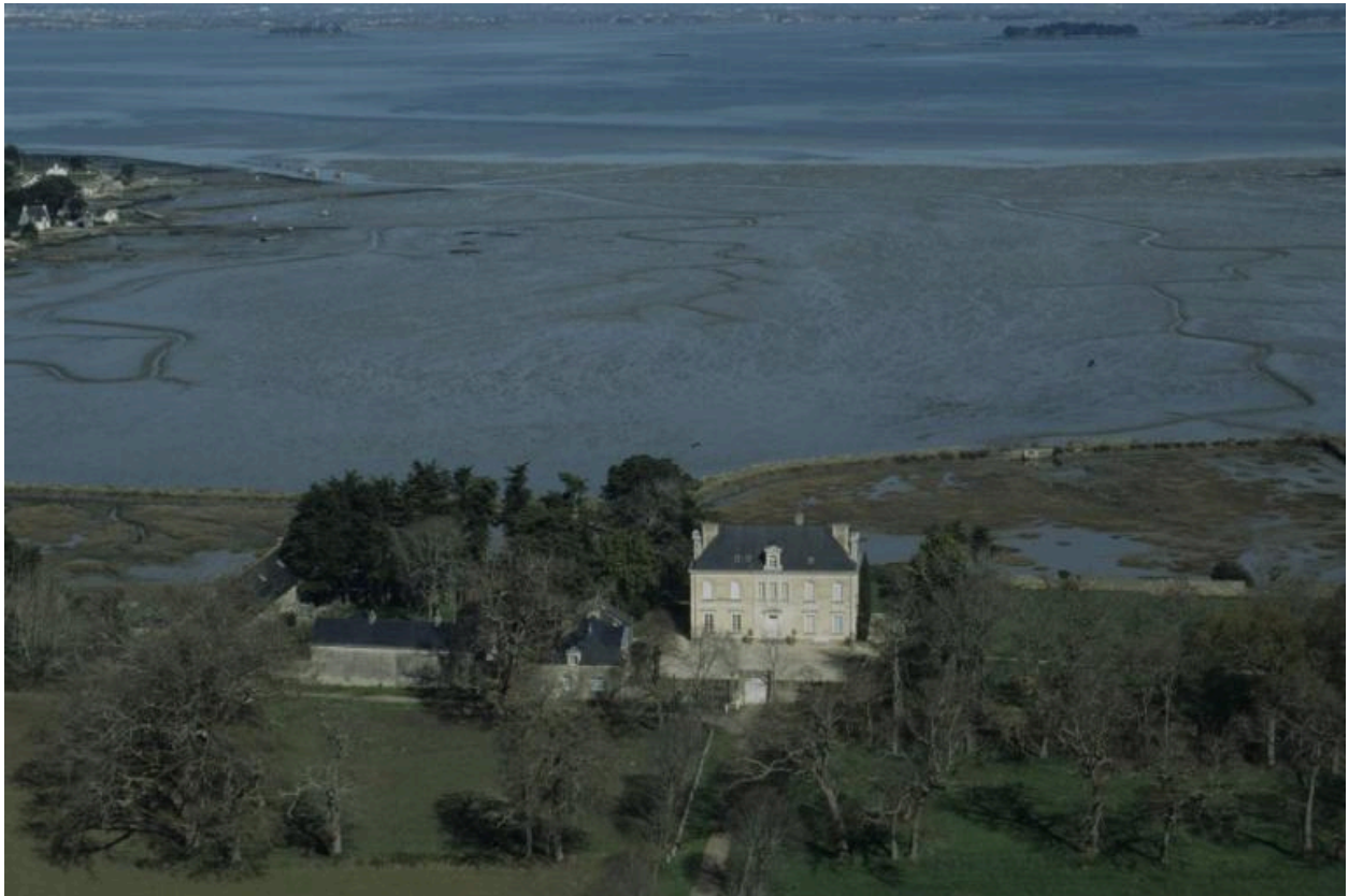
Vue aérienne sud.
