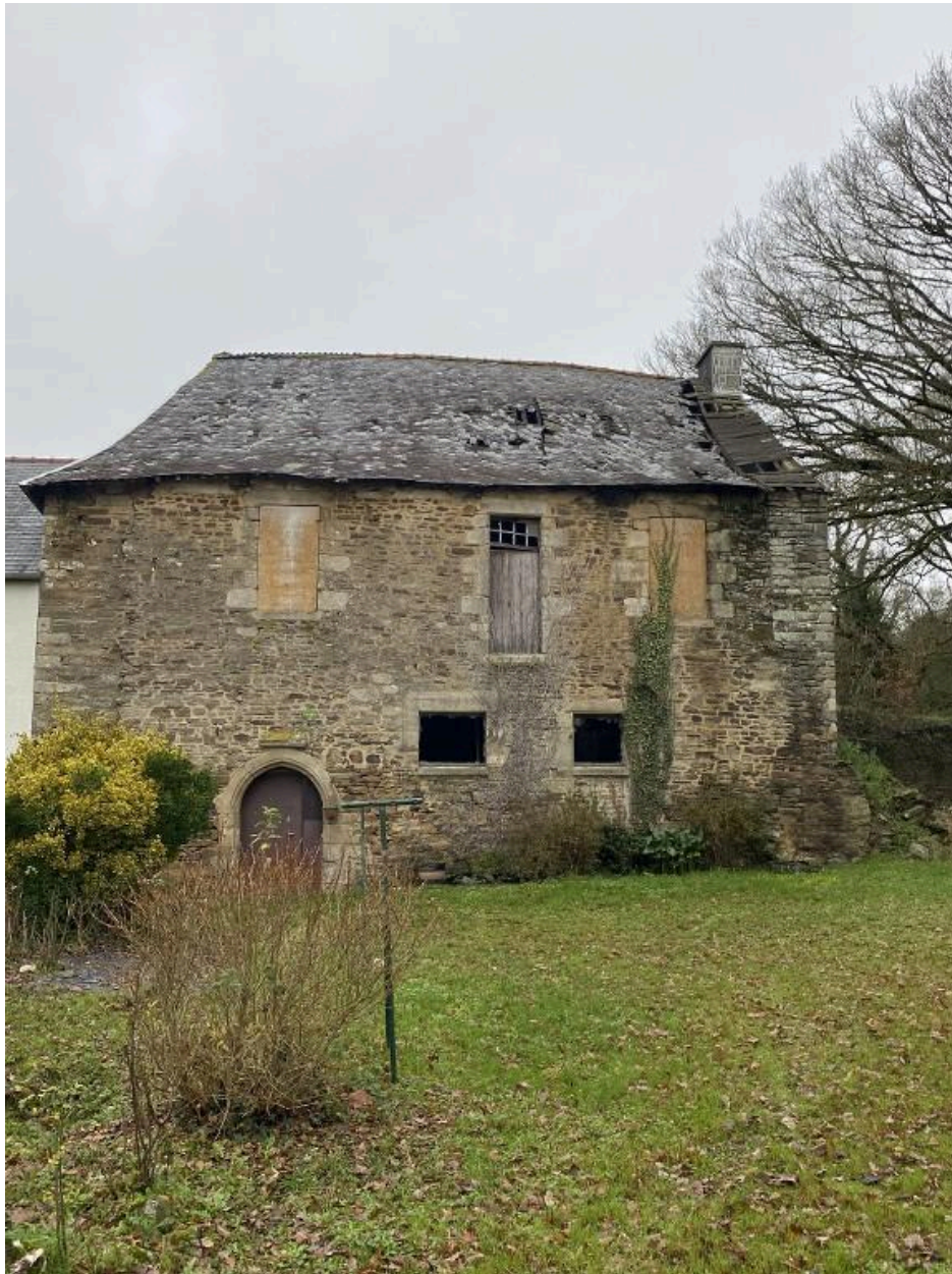
Élévation sud, vue générale
