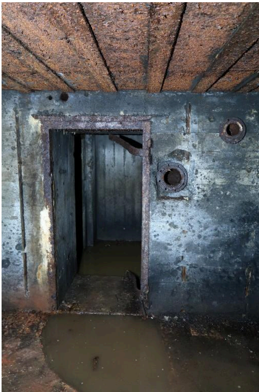
Vue de la salle de garde sud : porte d'accès. A droite, emplacement du ventilateur
