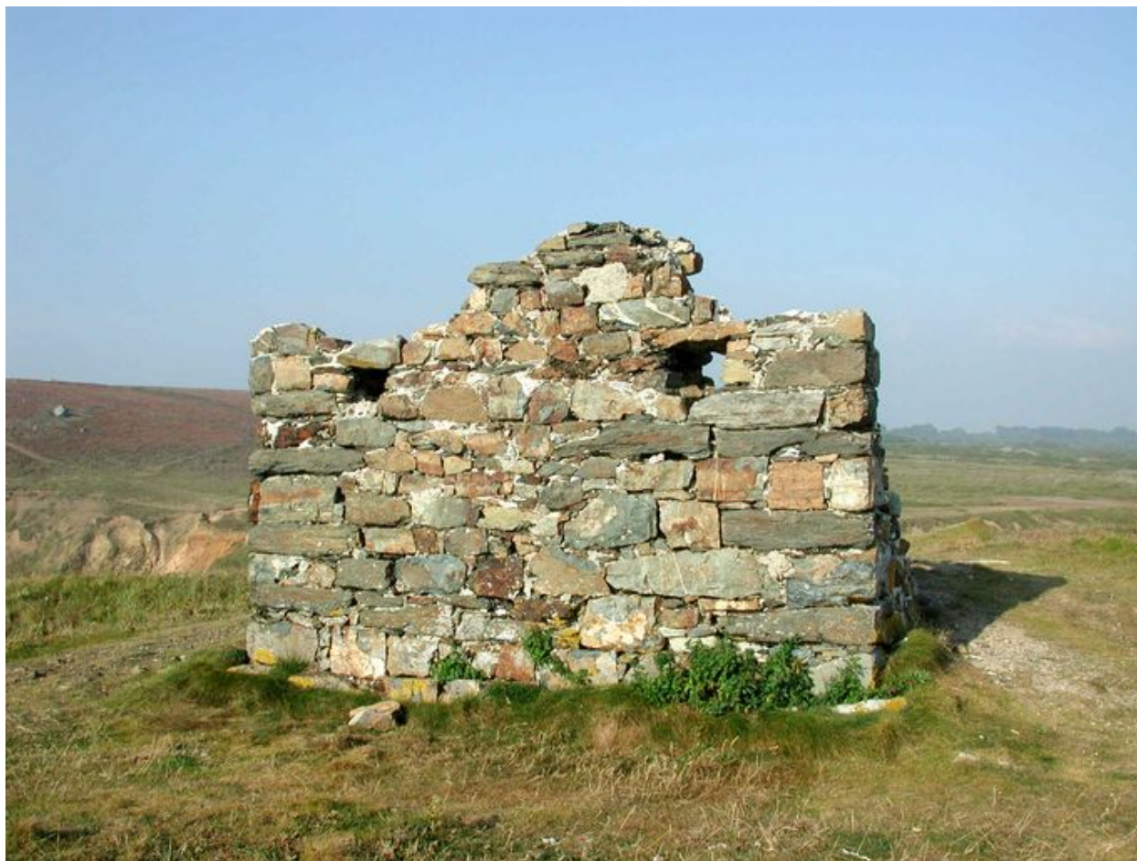
Vue du corps de garde
