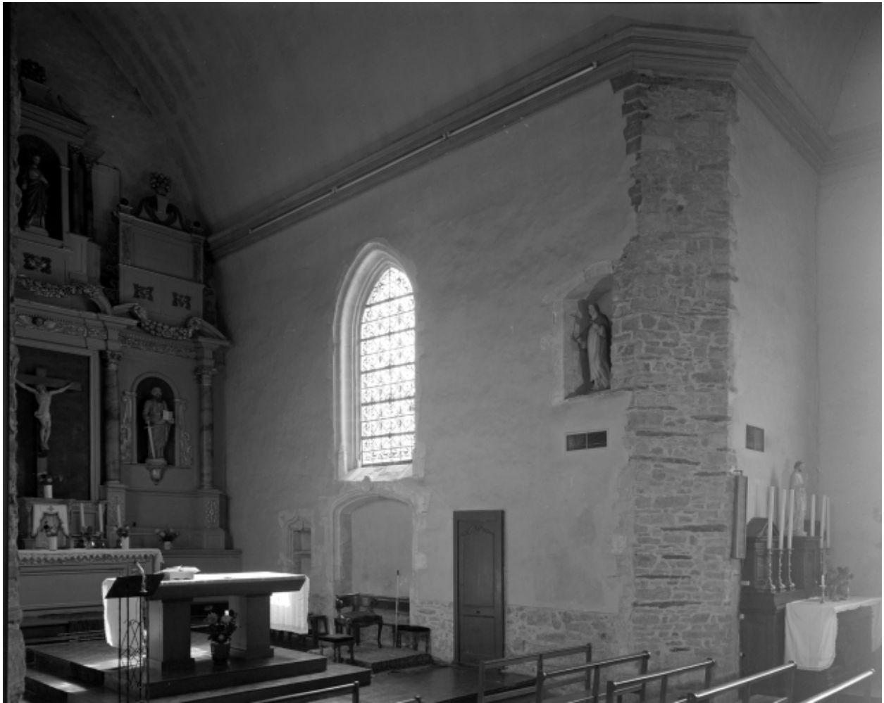
Choeur, vue générale du mur sud prise du transept nord.
