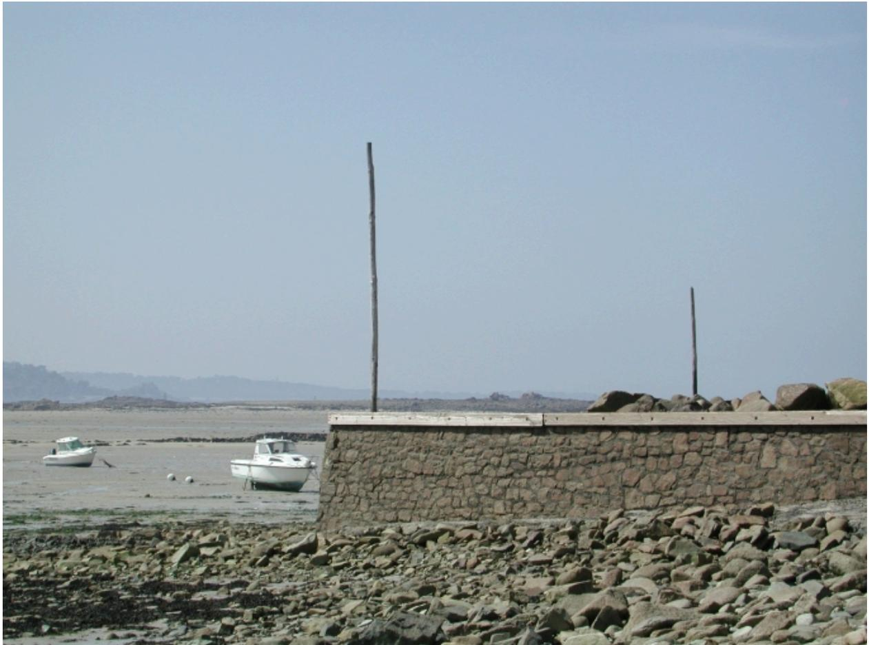
Le quai d'accostage construit en moellons maçonnés : remarquer le vaigrage en bois
