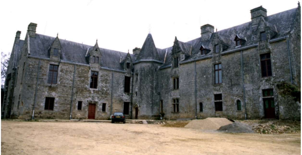
Château : les élévations sur cour (état en 2004)
