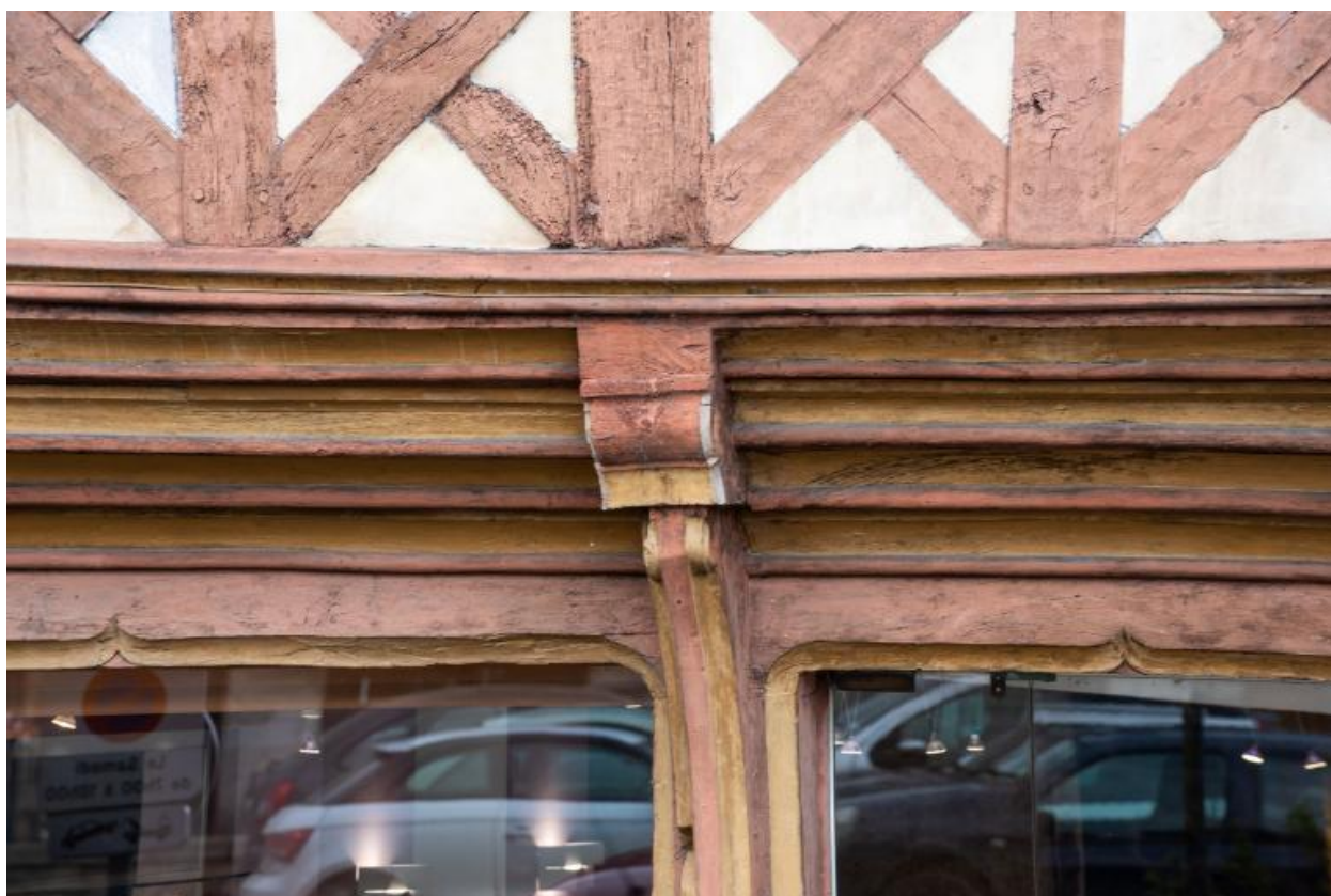
Détail de l'encorbellement et du décor en accolades
