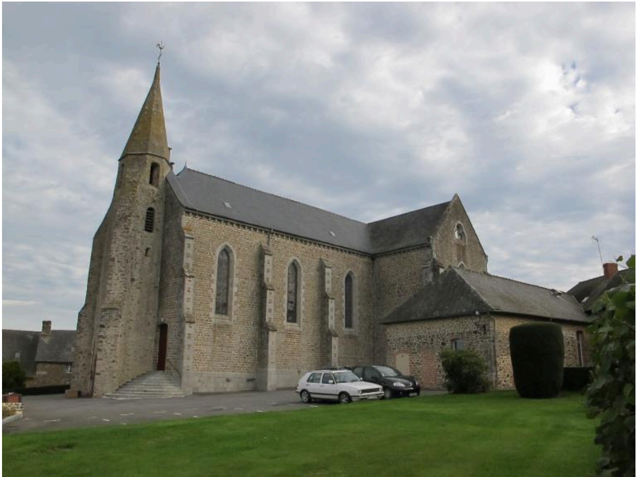
Vue générale : côté sud-ouest
