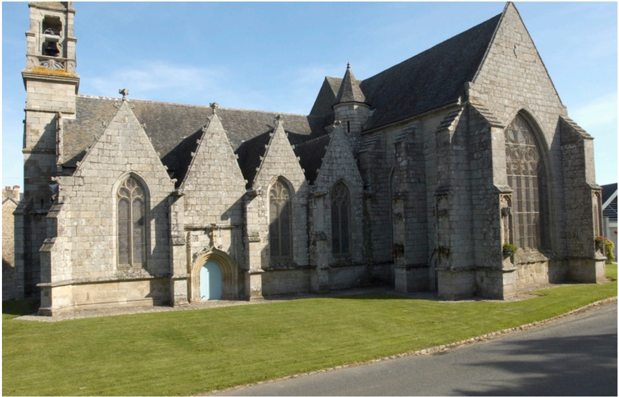
Vue biaisée façade sud et bras sud.
