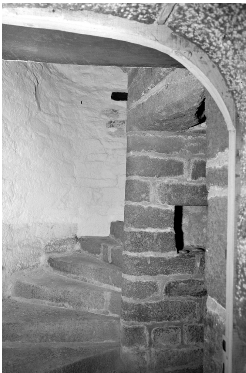
Tourelle : détail de l'escalier
