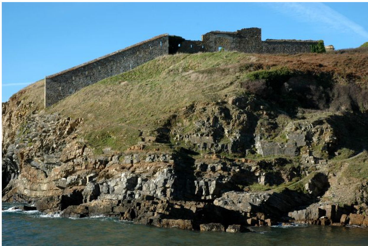
Roscanvel : mur défensif percé de créneau de fusillade du fort de la Fraternité
