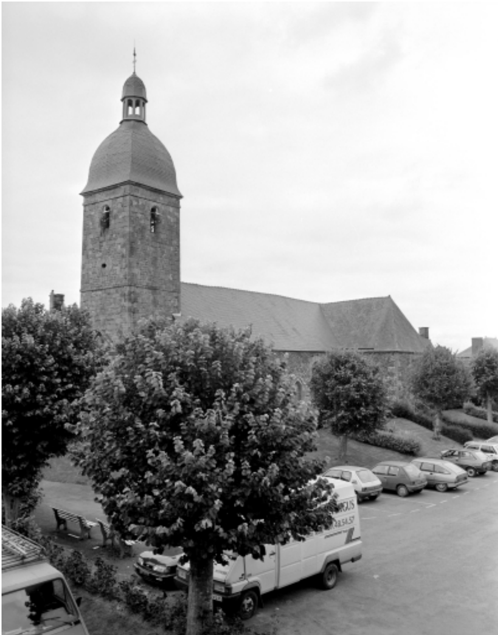
Elévation Sud-Ouest : vue générale
