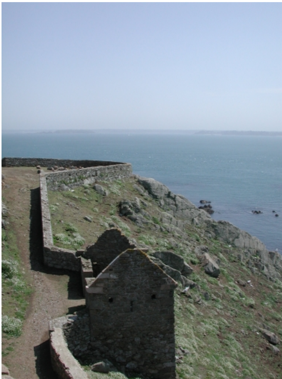
Vue générale des murets défensifs côté sud, près du corps de garde
