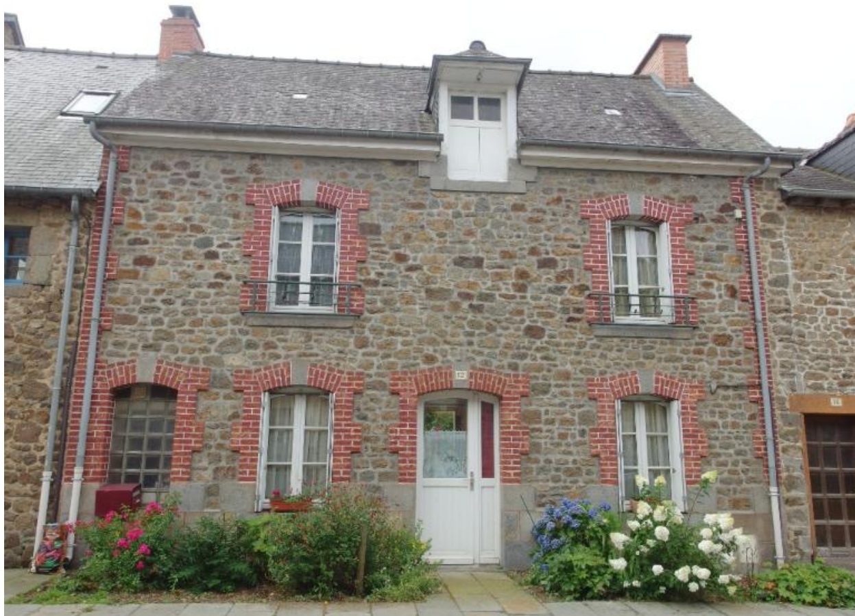
Vue de la façade nord
