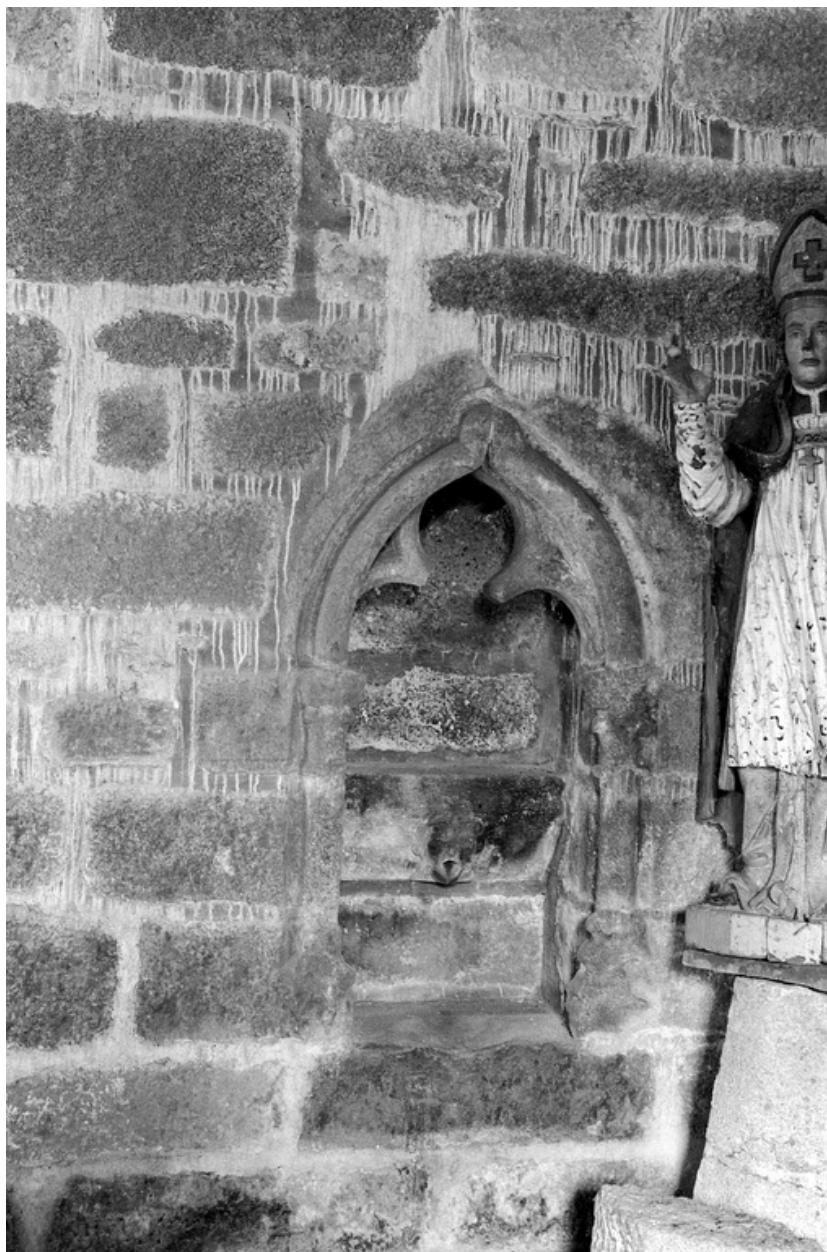
Vue de la crédence située au mur est
