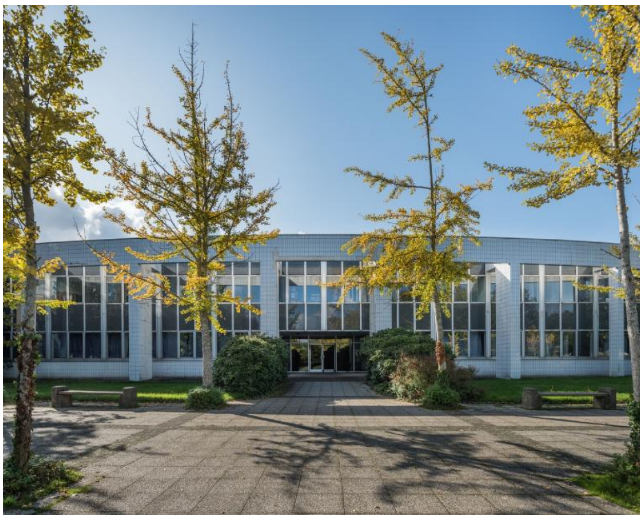
Façade est du centre d'information et de documentation : détail.
