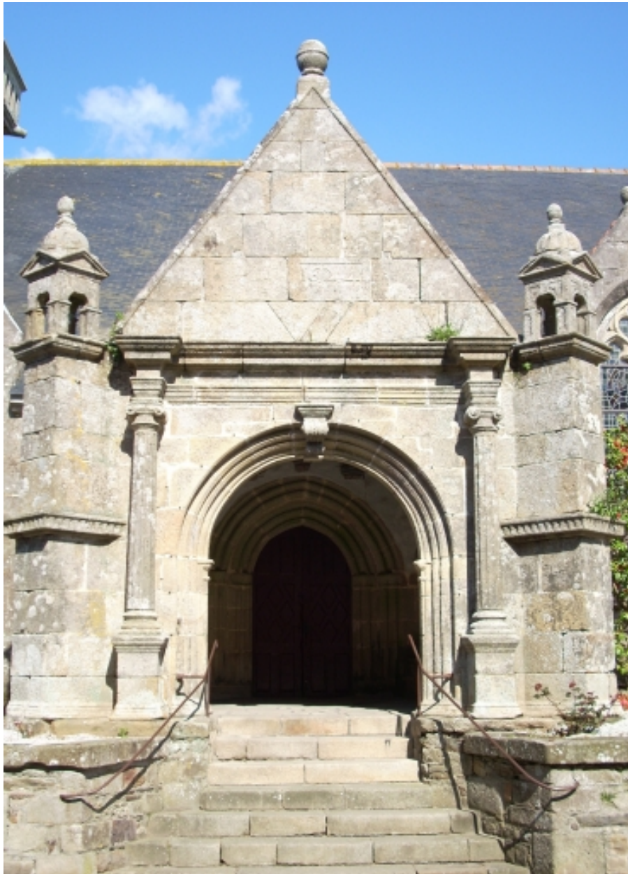
Plomodiern, église paroissiale Saint-Mahouarn : porche sud
