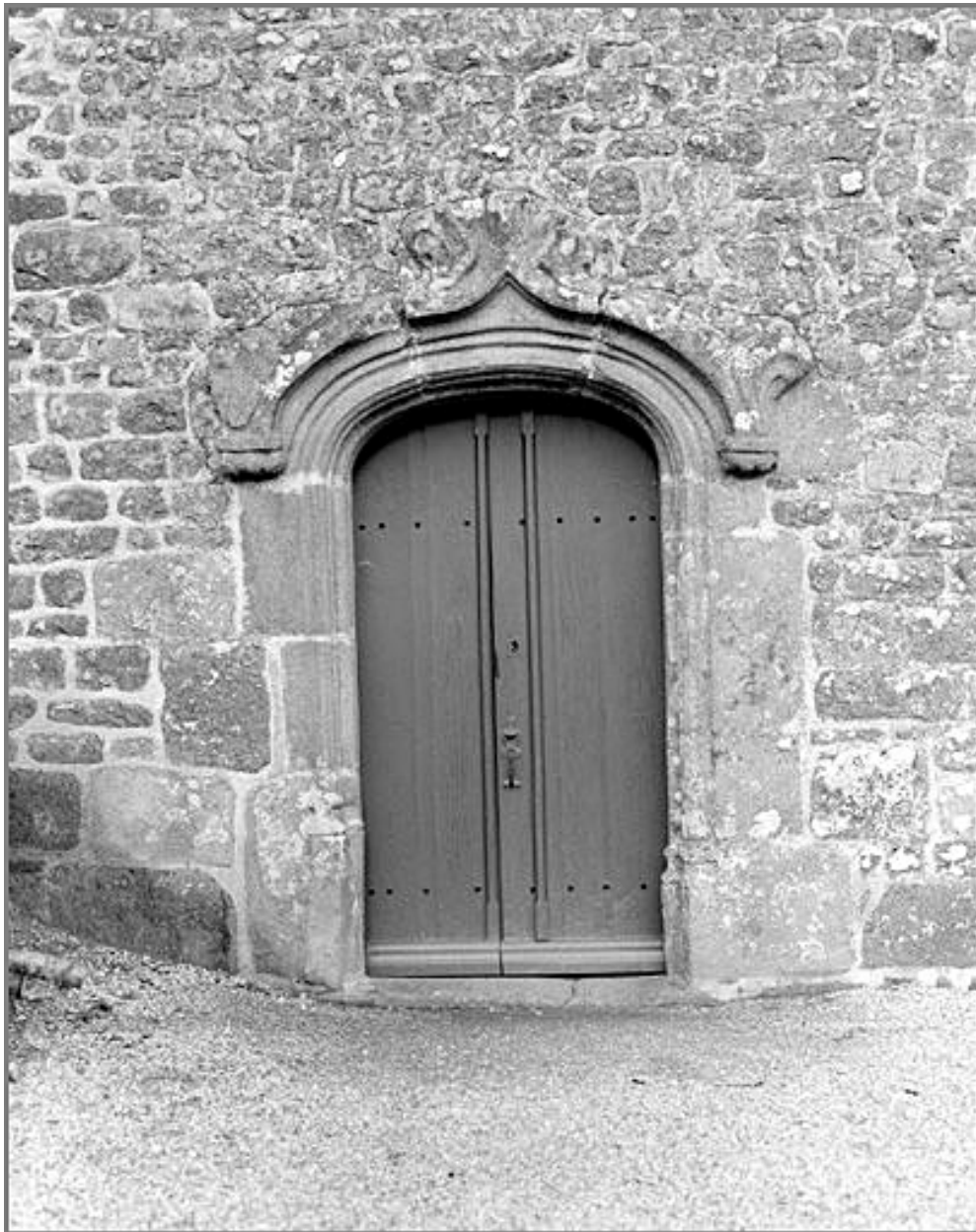
Elévation Sud, porte Est : vue générale
