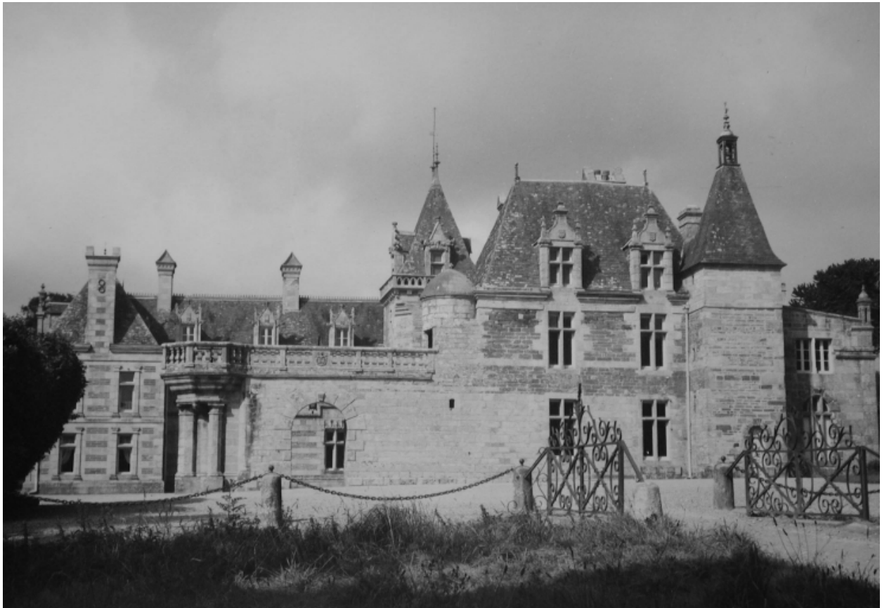
Façade est et galerie (C.R.M.H. Bretagne)
