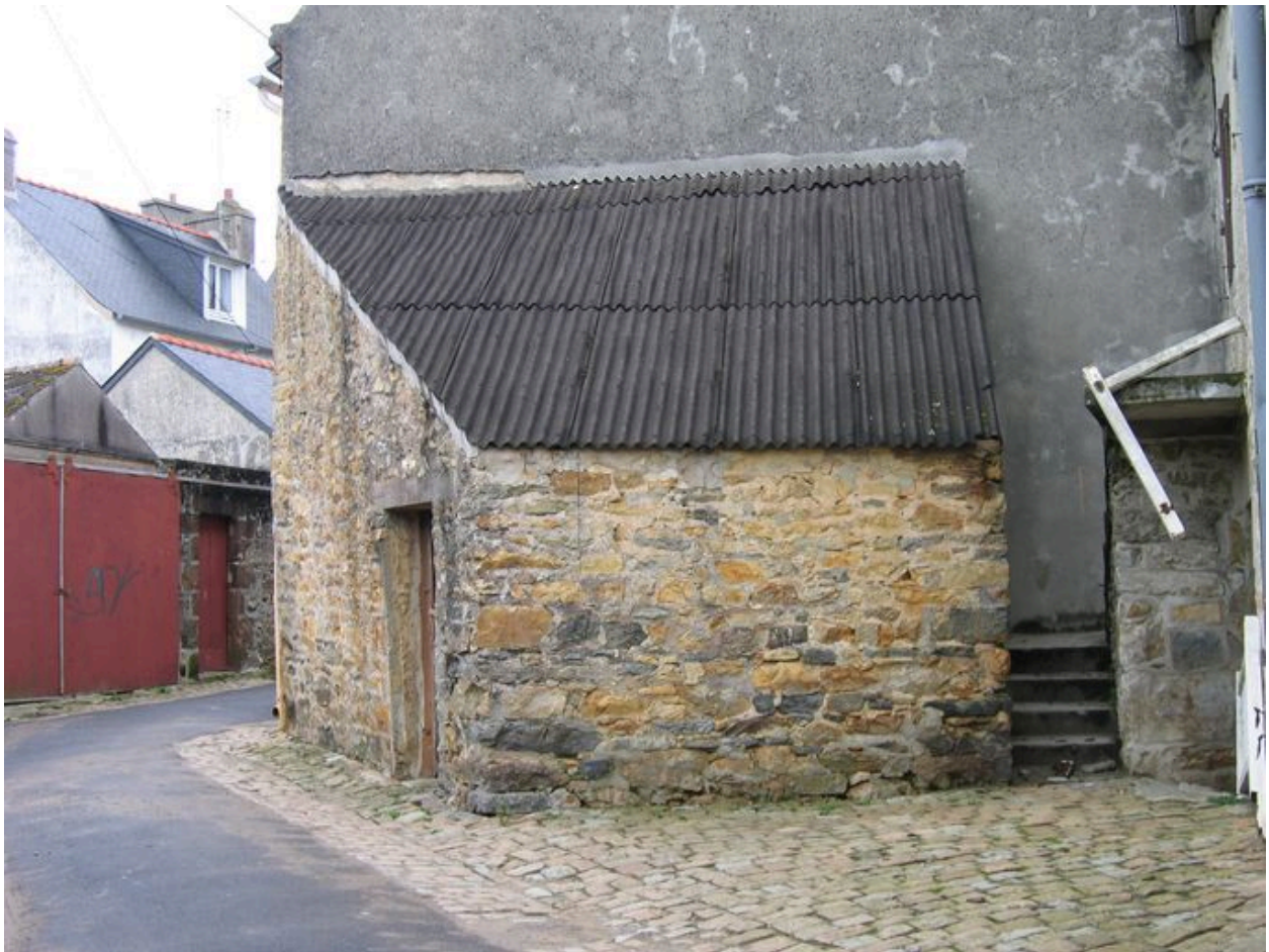
Maison au 9 rue de Bruxelles avec escalier extérieur
