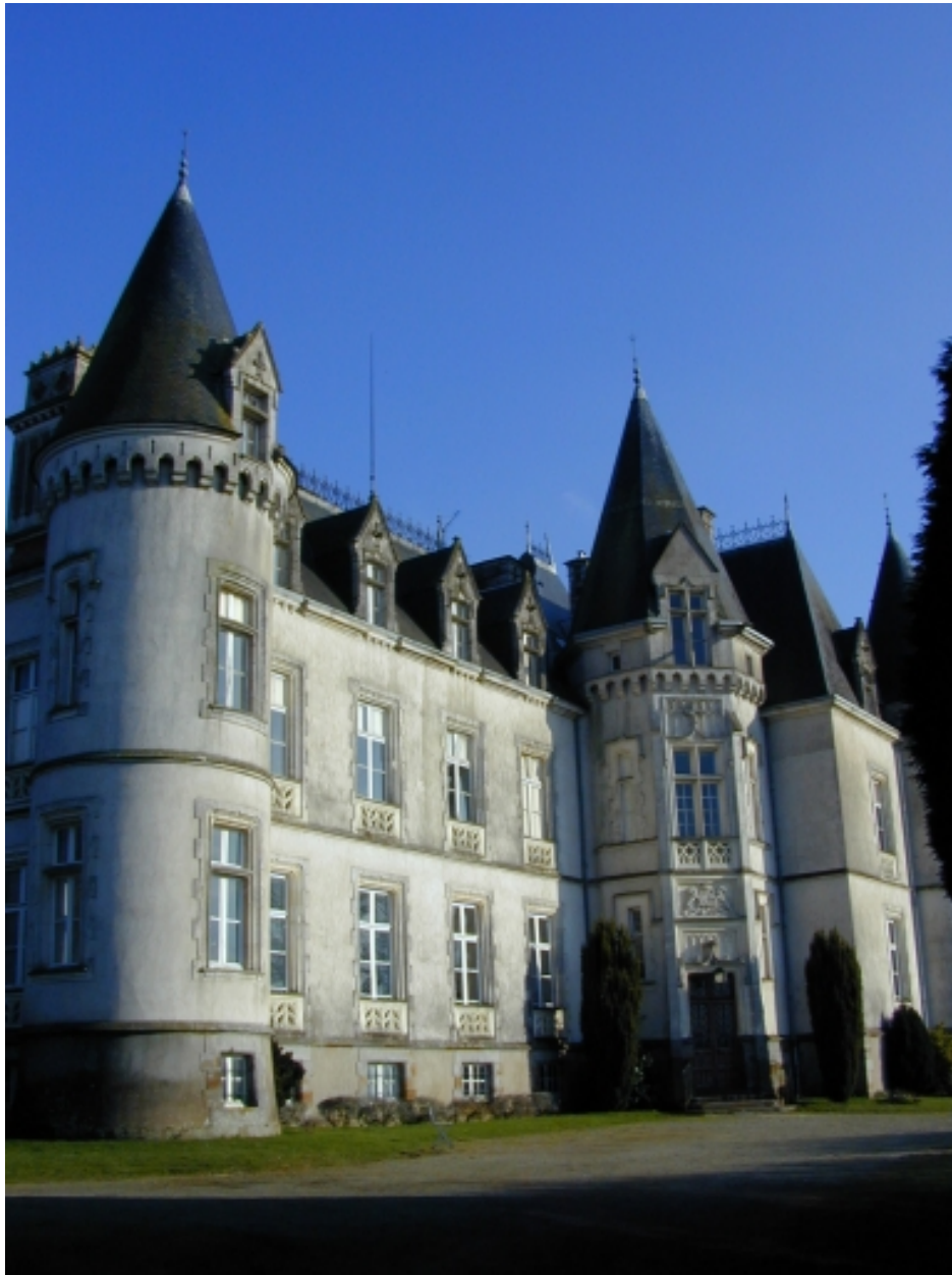
Vue partielle sud-ouest
