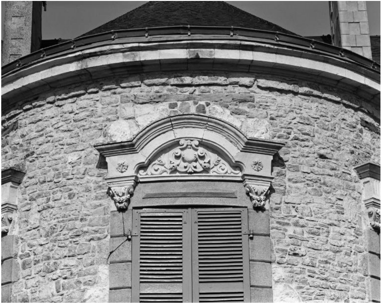
Elévation est, fenêtre centrale, linteau.
