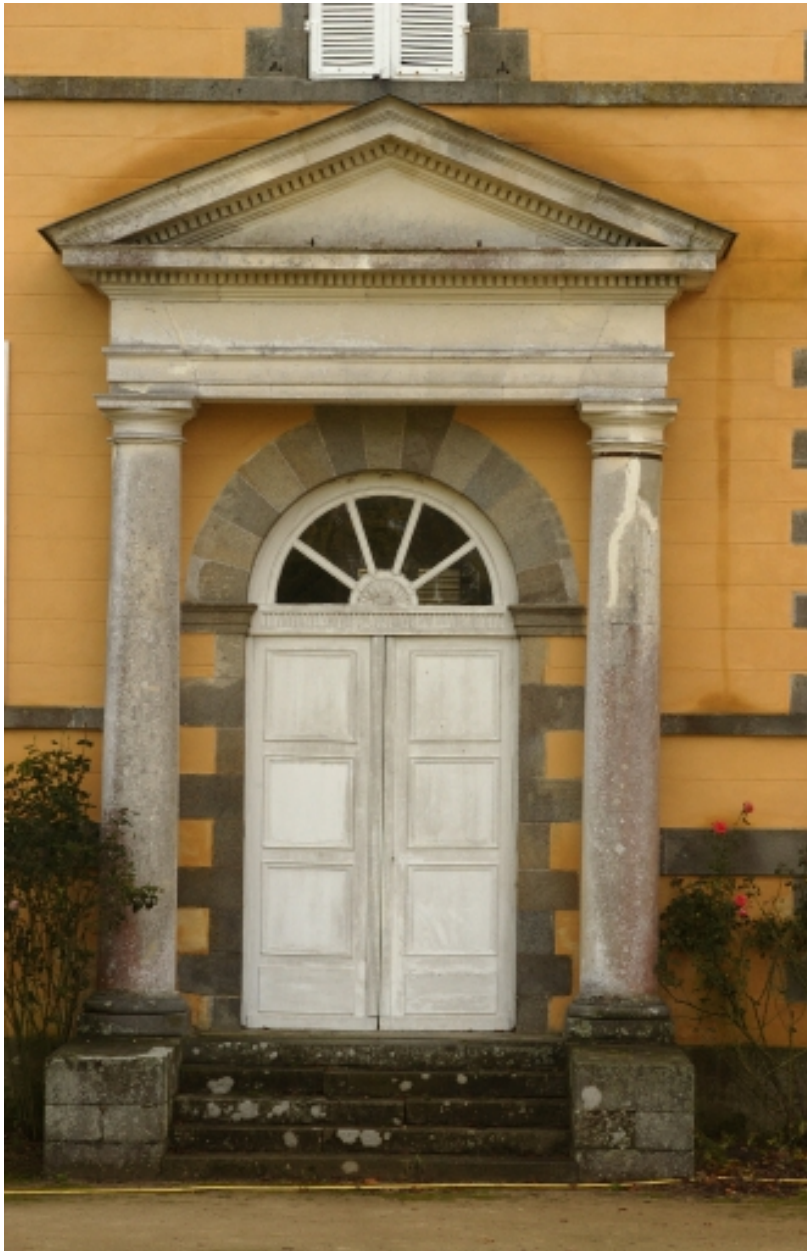
Elévation ouest : détail du porche d'entrée
