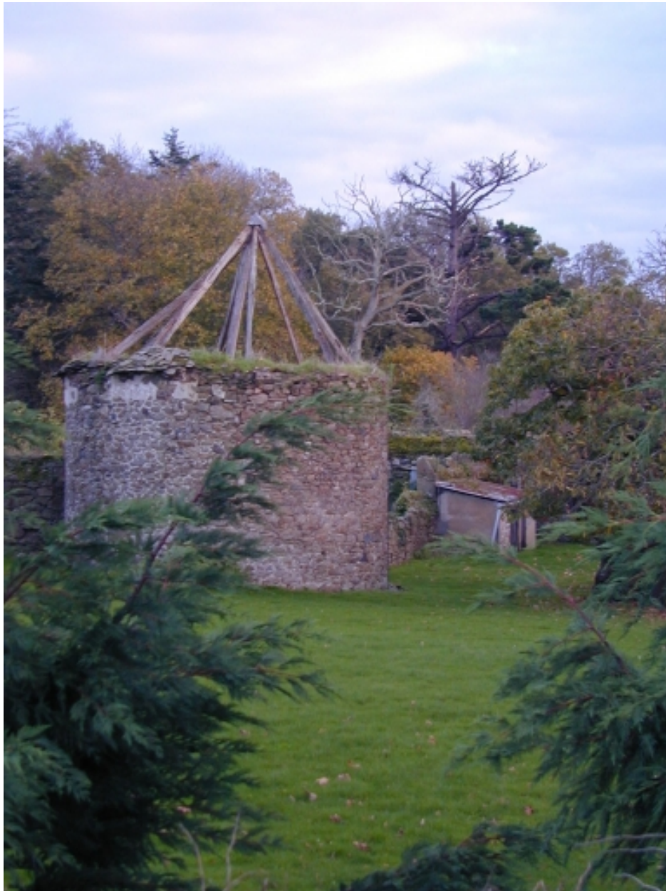
Le pigeonnier : vue générale nord
