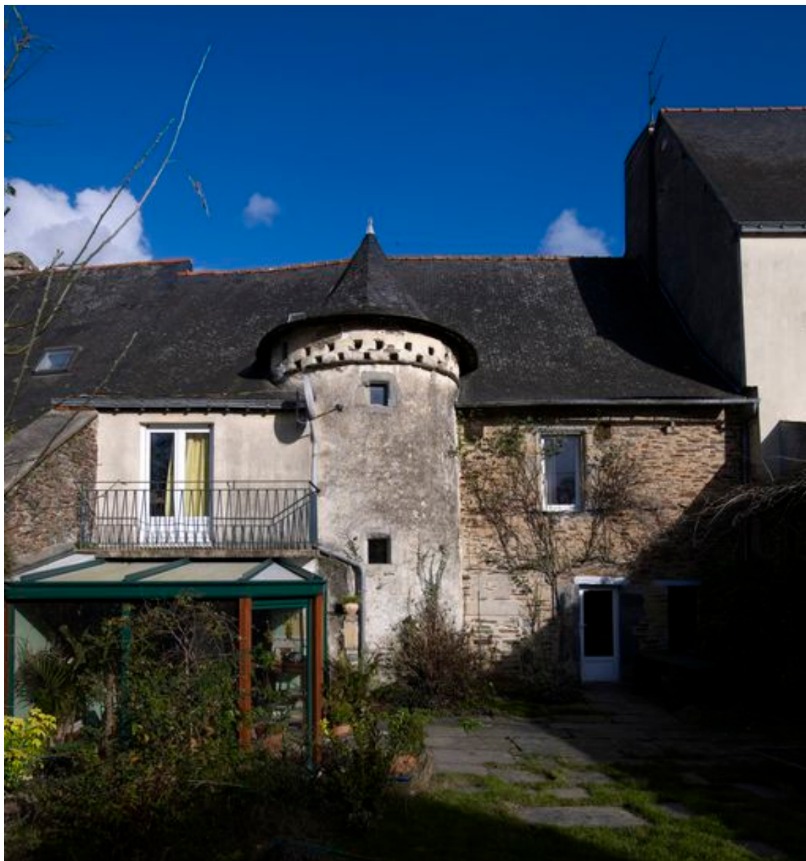
Maison : élévation postérieure (état en 2012)
