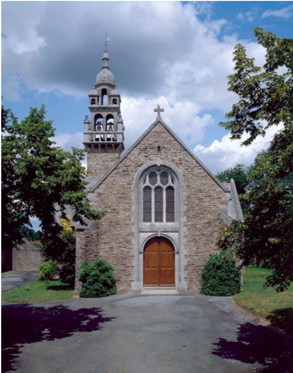
Élévation sud : vue générale
