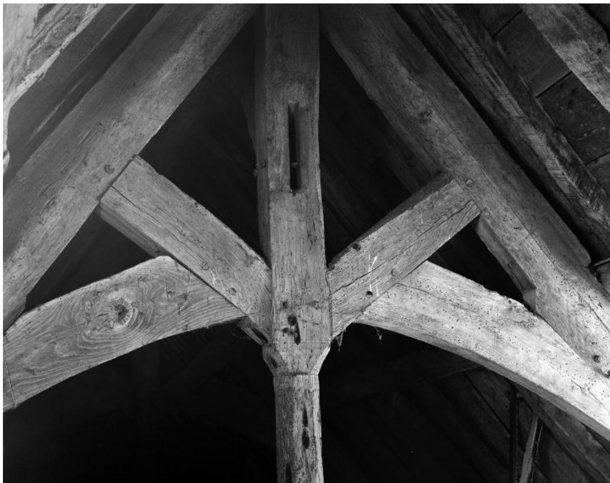
Corps central, charpente, détail
