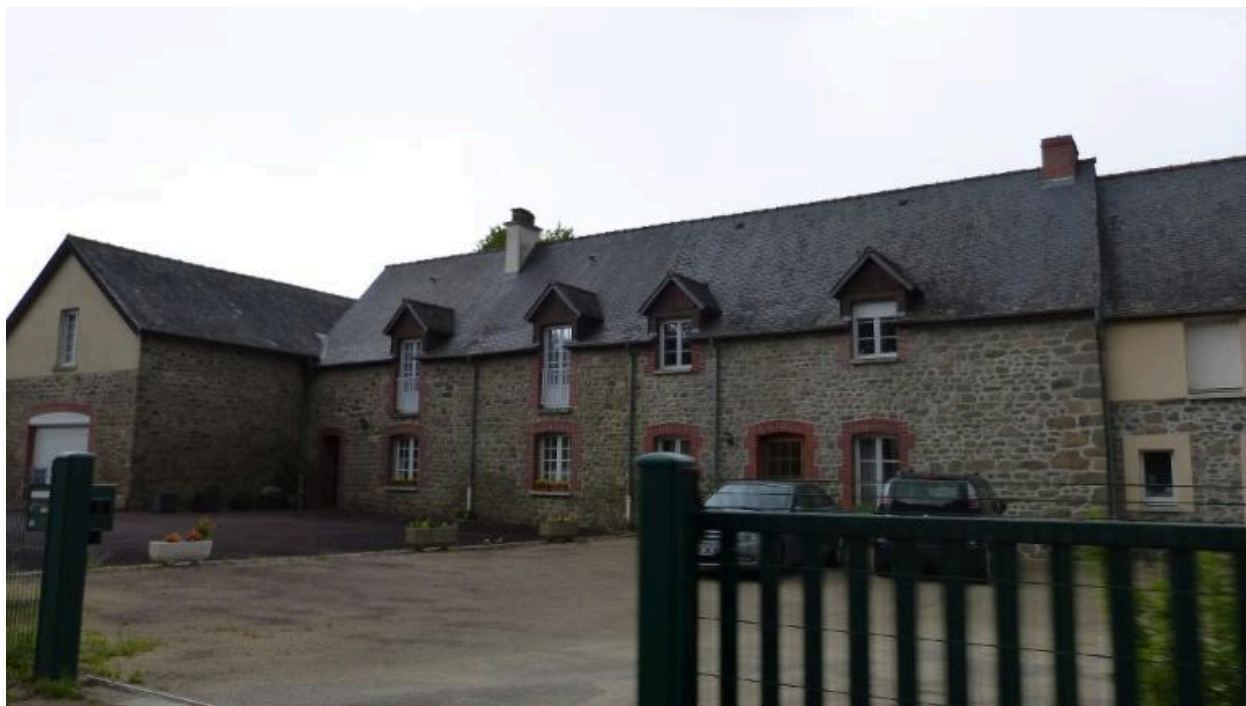
Vue générale sud, 13 La Parfraire (Hédé-Bazouges)
