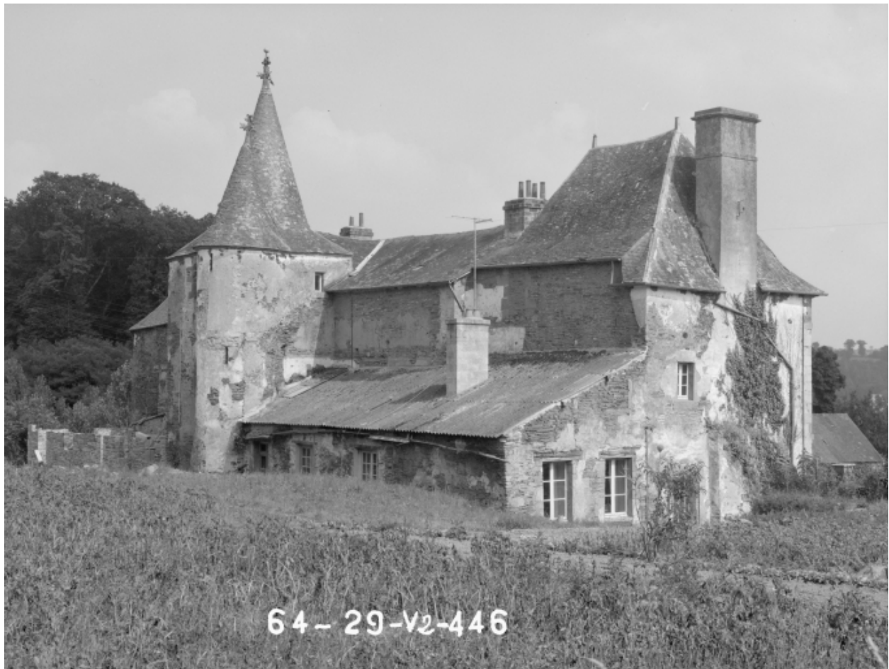
Façade postérieure prise du nord-ouest
