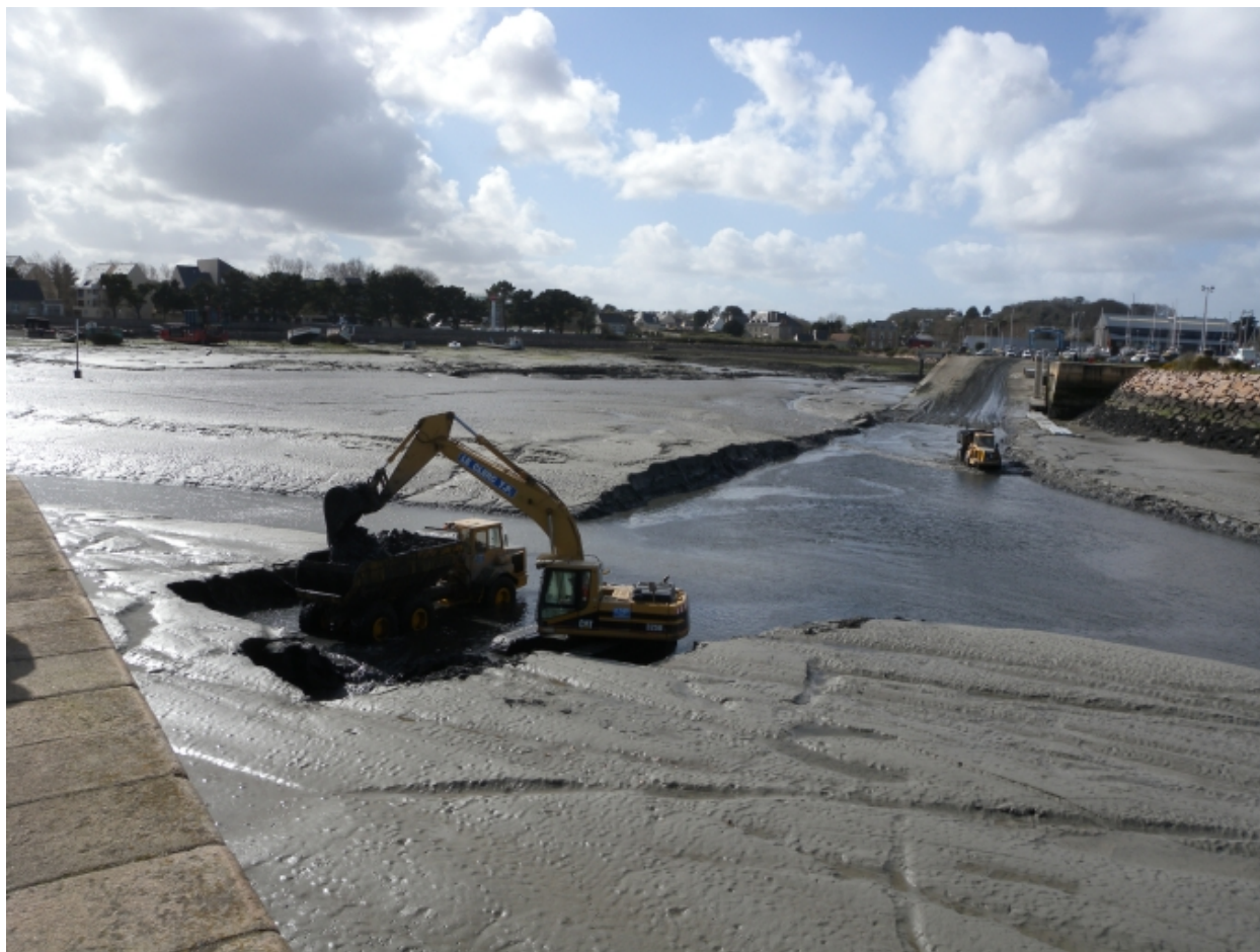
Vue de l'avant-port entre la cale de Kerpallud et la jetée de Kerno (opération de désenvasage)
