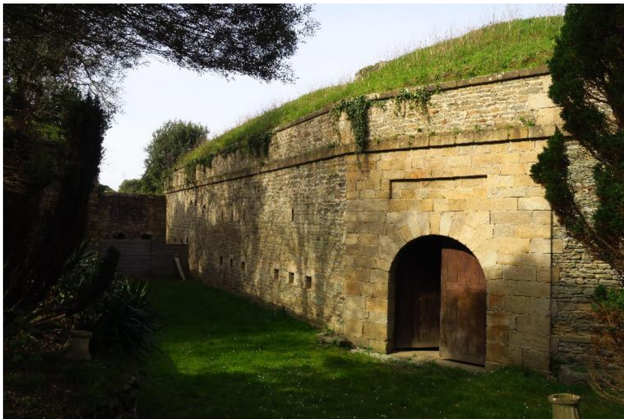
Le Palais, enceinte urbaine, réduit B, façade frontale, partie droite.
