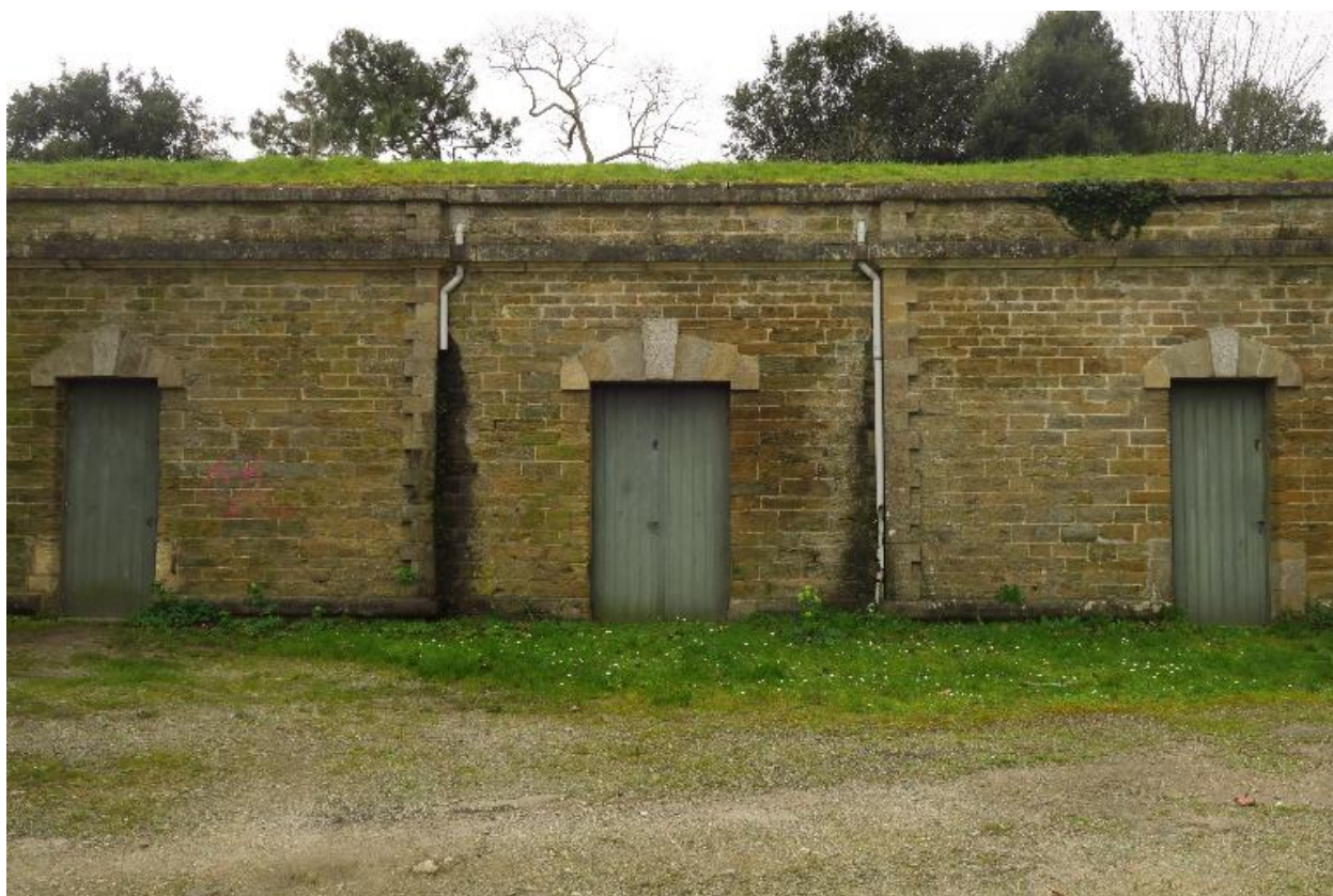
Le Palais, enceinte urbaine, réduit C, façade de gorge, partie centrale.
