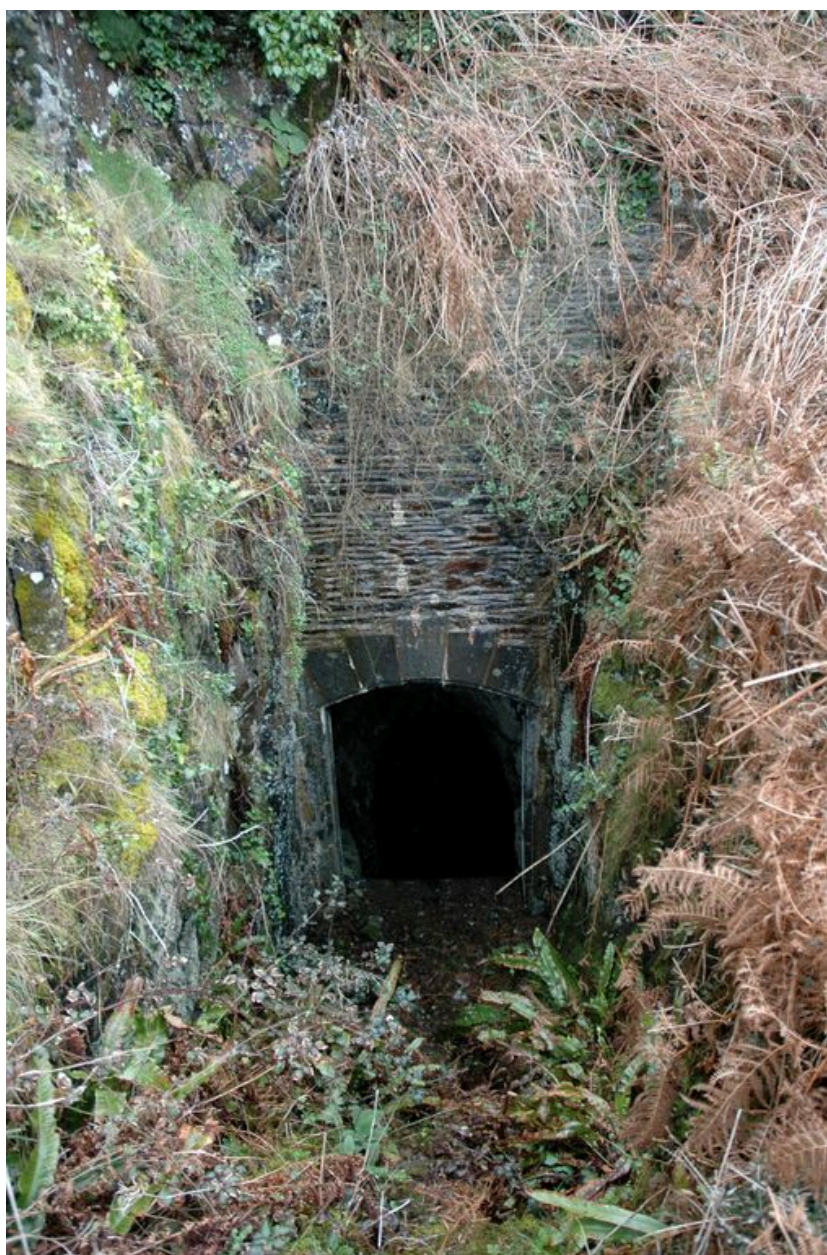
Vue de l'entrée de l'escalier (état en 2007)
