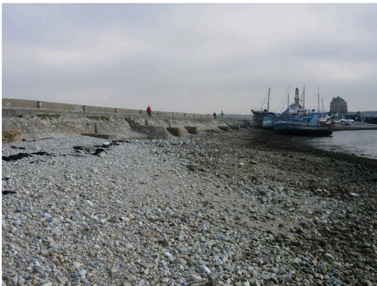
Vue de la digue depuis la grève
