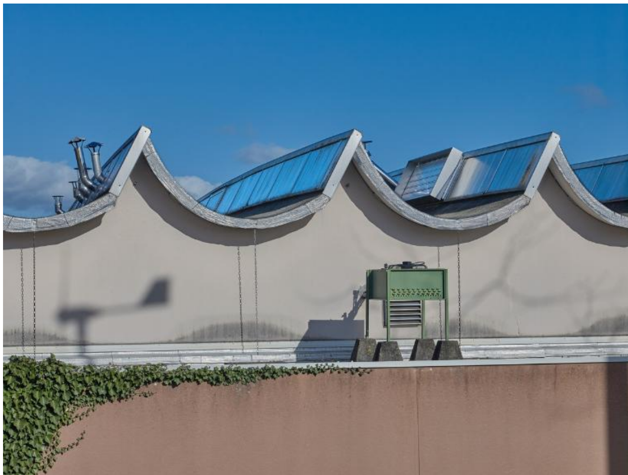
Ateliers : détail de la toiture. Roger Besnard, architecte, 1973.
