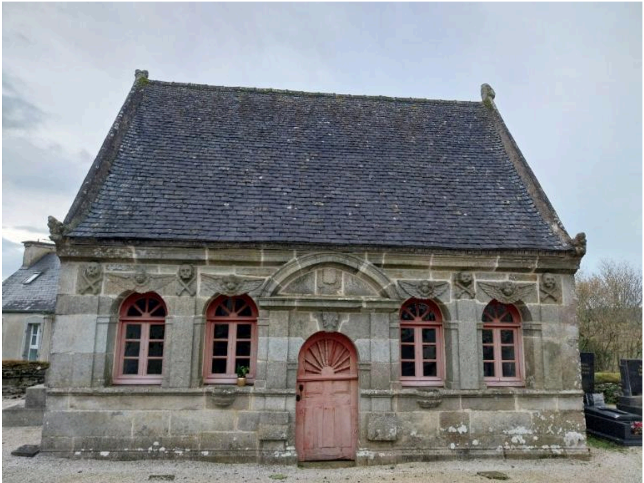
Ossuaire, vue de face de la façade est
