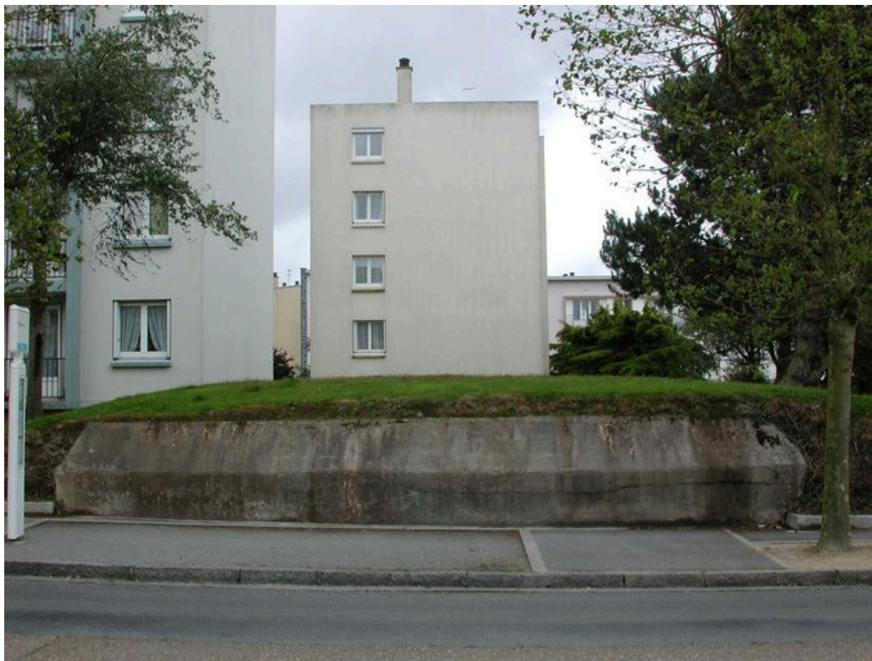
Vue générale côté rue : mur ouest et dalle de couverture (état en 2002)
