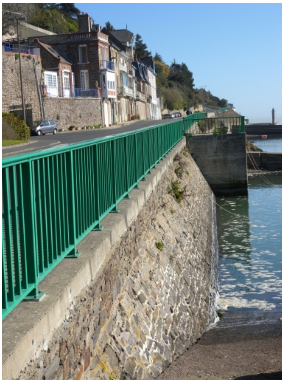
Vue des murs de soutènement et de la rampe
