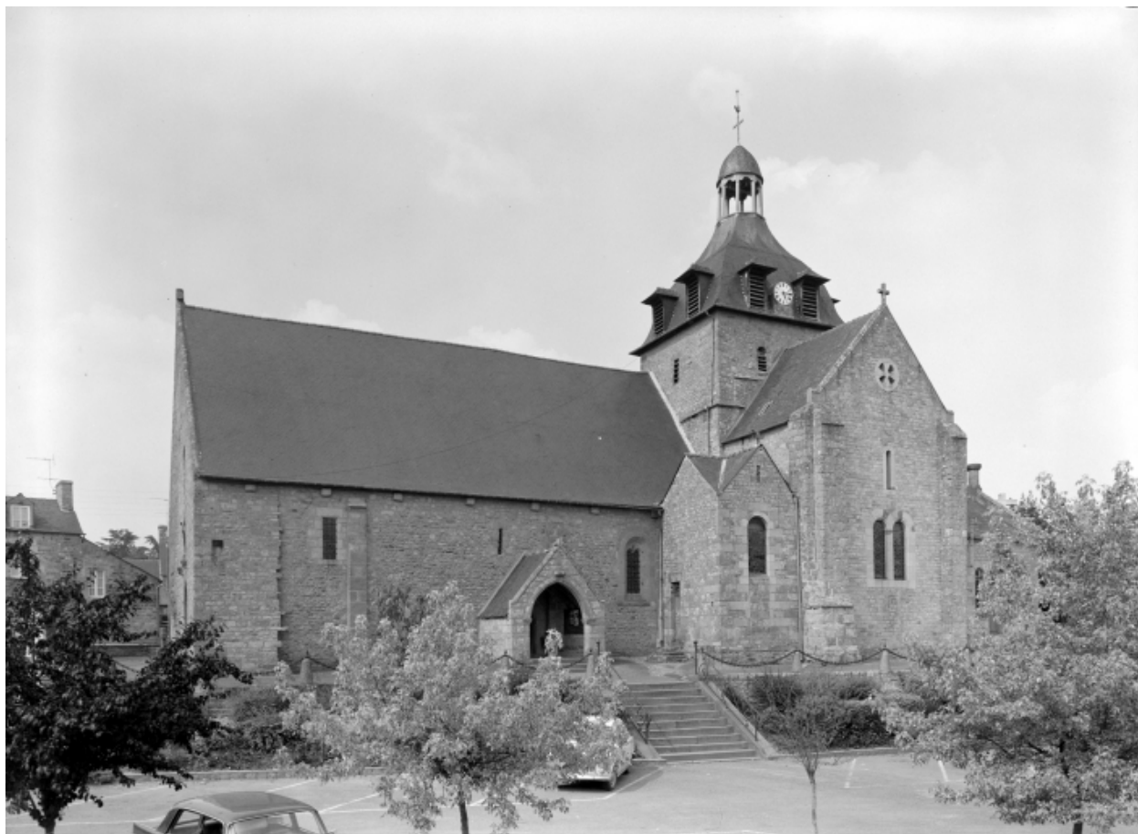
Elévation sud : vue générale
