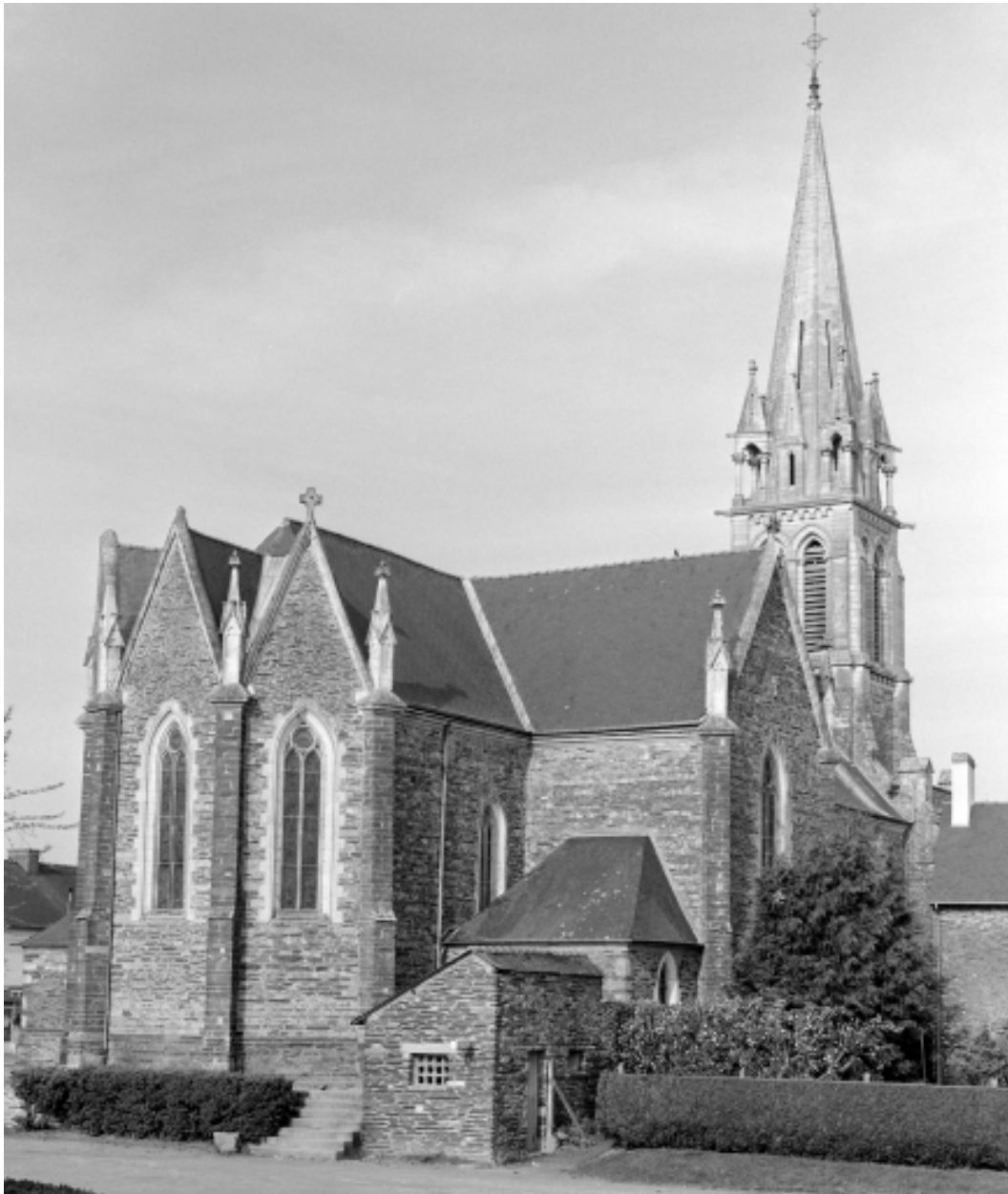
Elévation Nord-Est : vue générale
