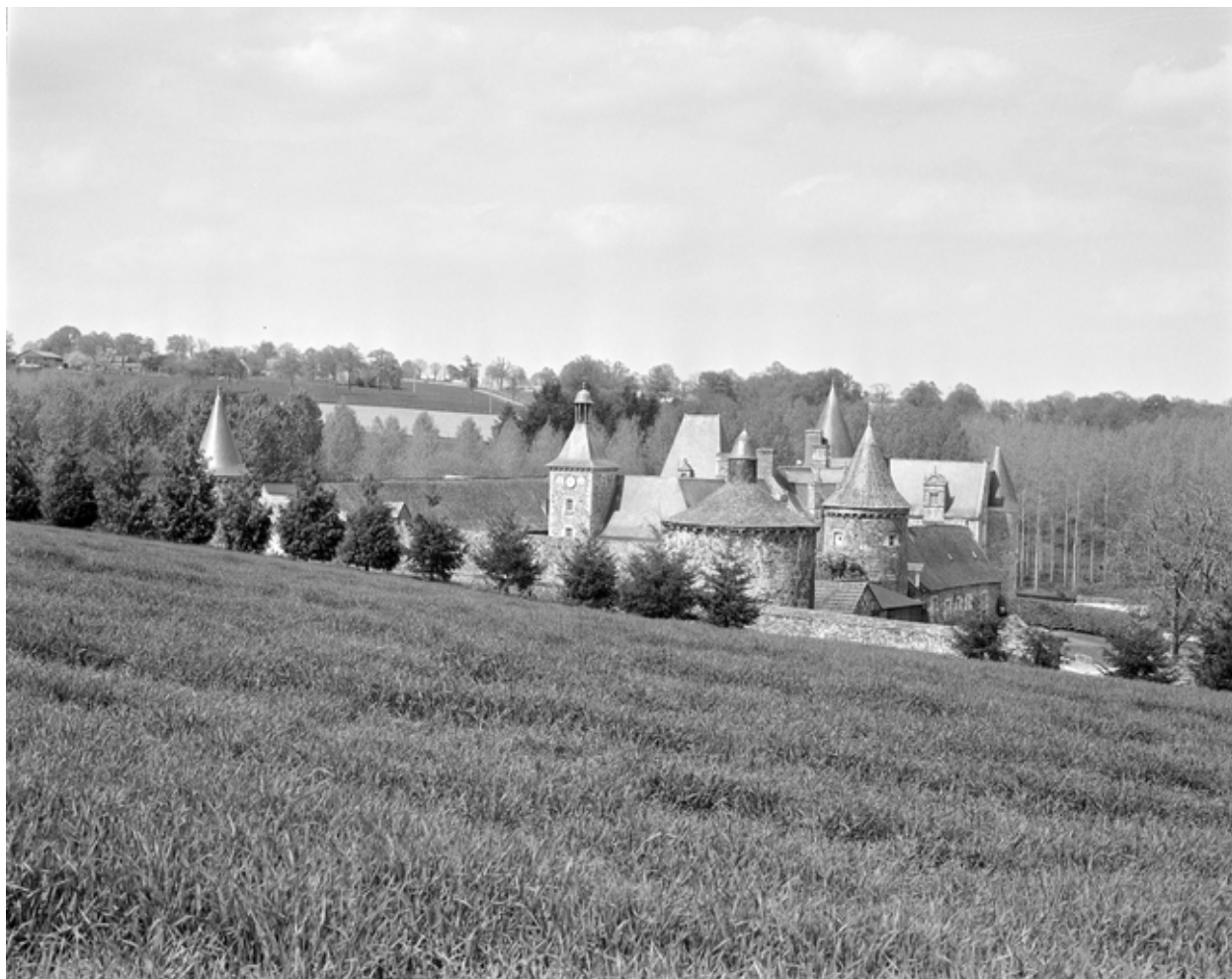
Vue de situation sud-ouest.
