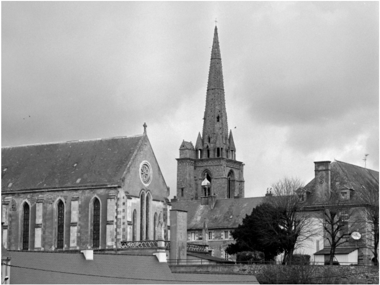
Elévation Sud-Ouest, clocher, fèche : vue générale
